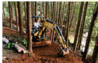
作業道を作っています
