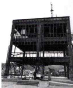
南三陸町 防災センター
