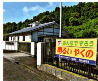
上地区集落排水施設の入口付近に設置
