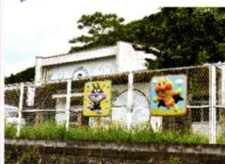
内部改装工事が進む旧中夜久野保育園舎
